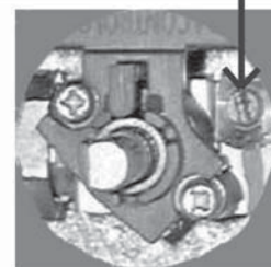
Vite del by-pass del bruciatore
