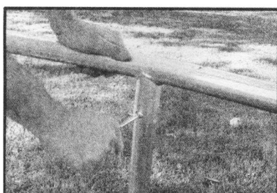
5. K hlavnímu rámu přišroubujte nejdříve zkompletované nohy
